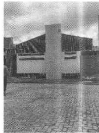
Fachada externa do Bloco de Serviço
