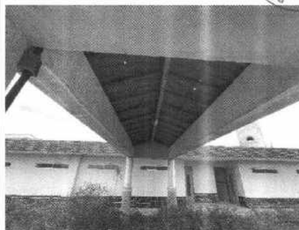
Coberta da Passarela
