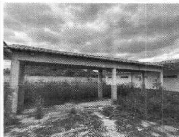
Vista da Passarela
