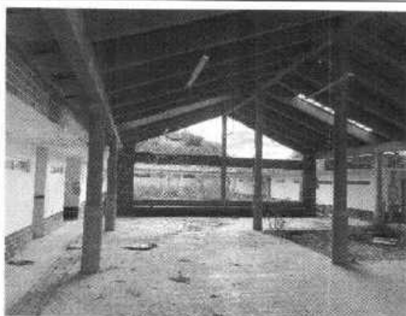
Pátio e Refeitório da Creche
