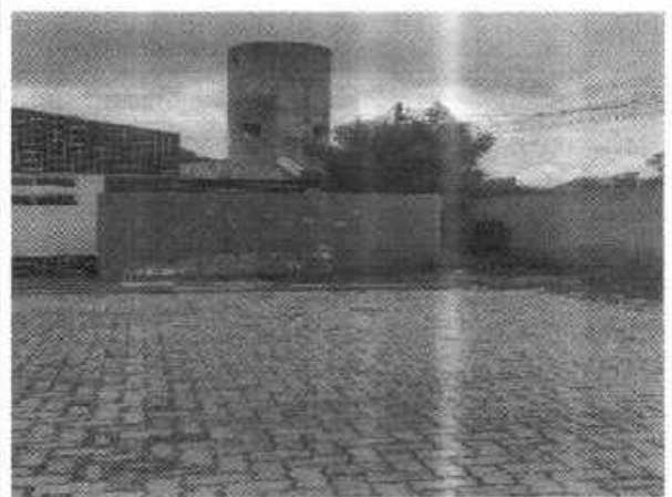
Vista do Castelo D'água
